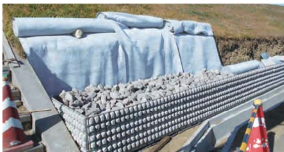
のり尻ドレーン工 (EGドレーン使用)
