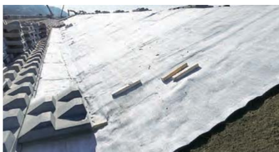
河川護岸(川表) ブロック敷設状況
