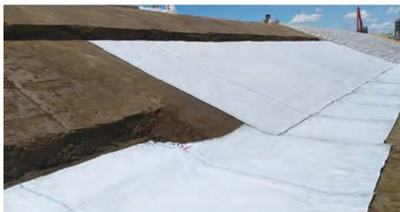
河川護岸(川裏)
